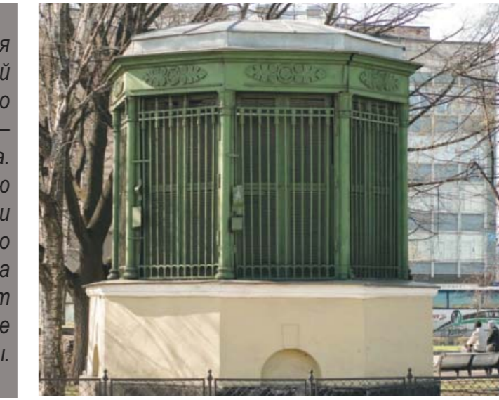
Эксплуатационная длина линий Петербургского метрополитена – 128,1 километра. Тоннельную вентиляцию и приток свежего воздуха обеспечивают 144 вентиляционные шахты.
