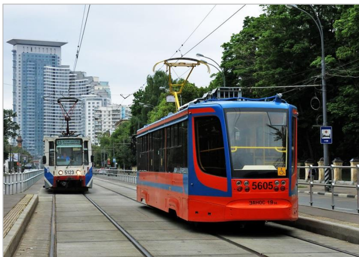
Трамвай на вновь обособленном полотне на ул. Стромынка, Москва
