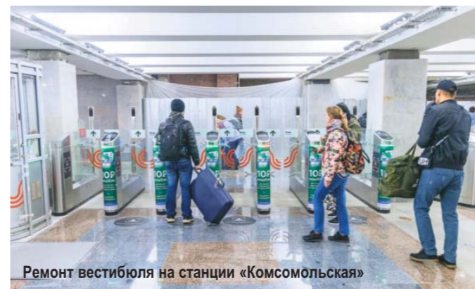
Ремонт вестибюля на станции «Комсомольская»
