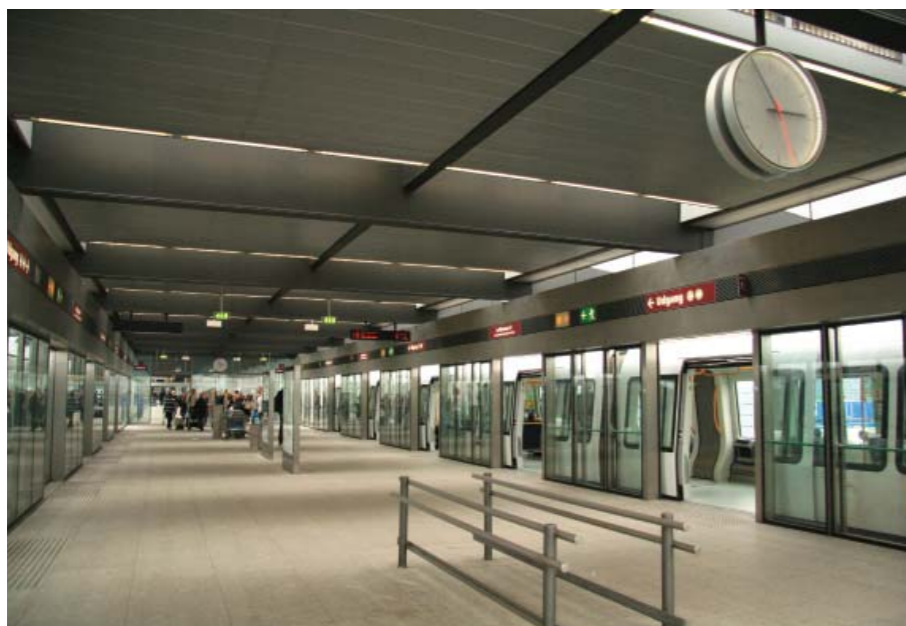
Станция мини-метро с автоматическими дверями, препятствующими падению пассажиров на путь
